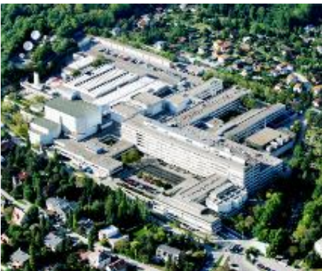
Sanierung Medienstandort ORF
